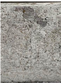
Fissure des appuis de fenêtre
