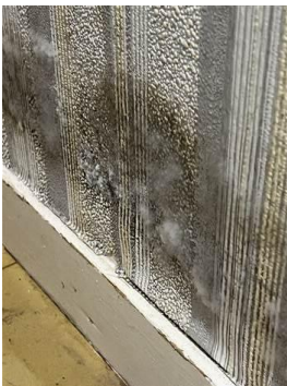
Présence de moisissures et de champignons sur un mur intérieur
