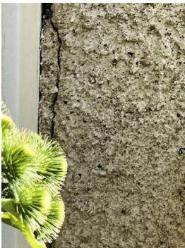
Fissure des tableaux de portes et fenêtres
