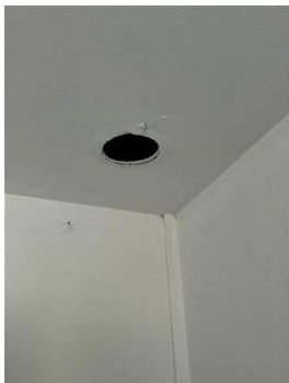
Bouche d'extraction VMC qui n'est pas fixée au plafond
