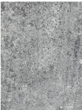
Microfissure sur crépi extérieur
