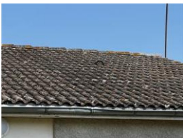
Présence de mousse sur la couverture
