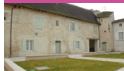
Lancement d'opérations d'acquisition-amélioration en centre-bourgs (ici l'acquisition de l'ancien couvent à Lençloître).
