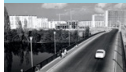
Début de la construction de la Plaine d'Ozon à Châtellerault.
